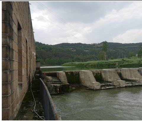
坝址处实时监控设施
