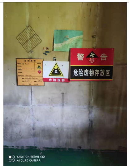
危废间内部照片
